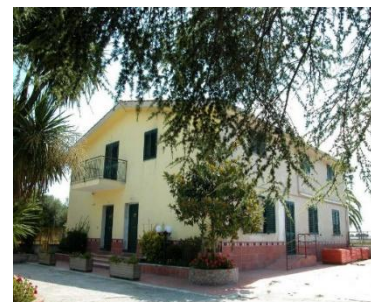
Esterno della struttura
